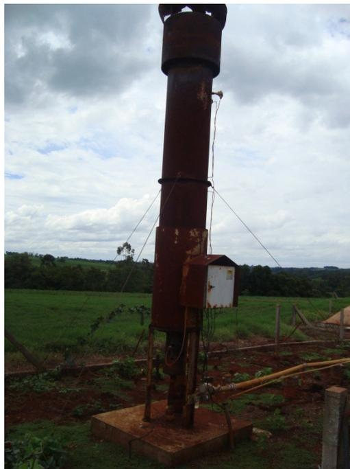
Figura 7: Queimador utilizado na queima do Biogás.
