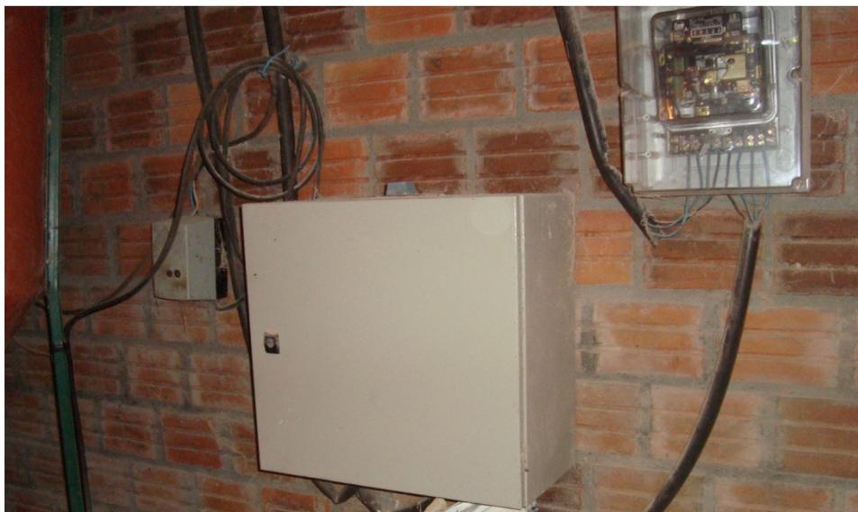
Figura 11: Ilustração da instalação de um painel seletor de energia manual.
