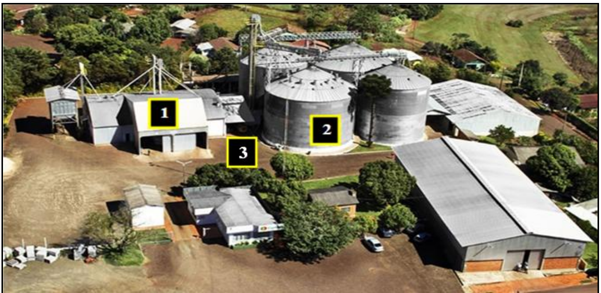
Figura 8: Visão geral CAMERA - Vila Pitanga – RS. Fonte: CAMERA S.A.
