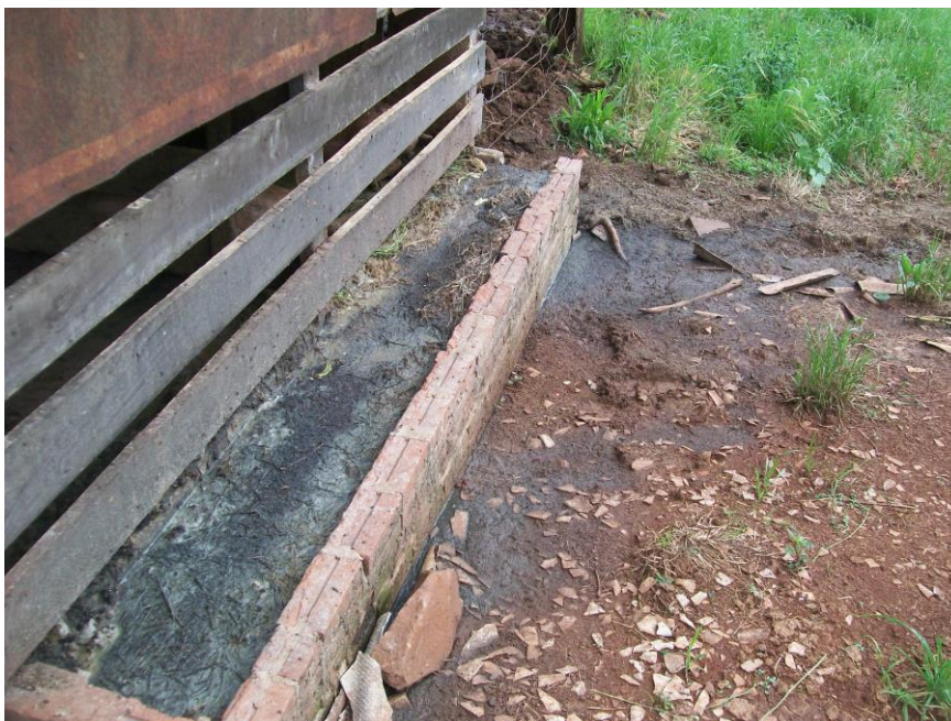
Figura 12 – Pocilga antes da instalação do biodigestor
