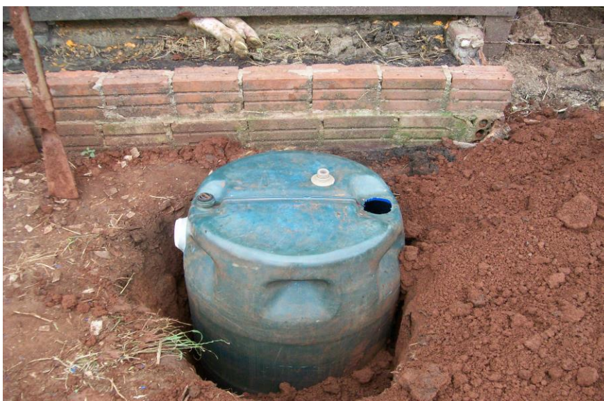
Figura 14 – Instalação da câmara de fermentação 1
