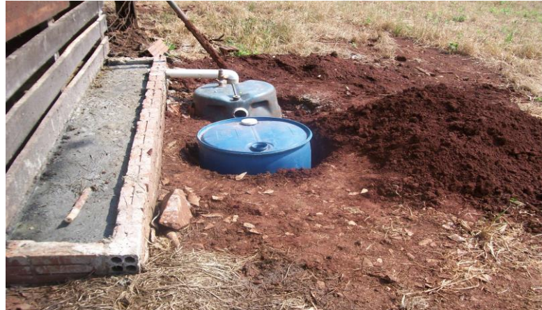
Figura 15 – Câmara 1 instalada e início da instalação da 2
