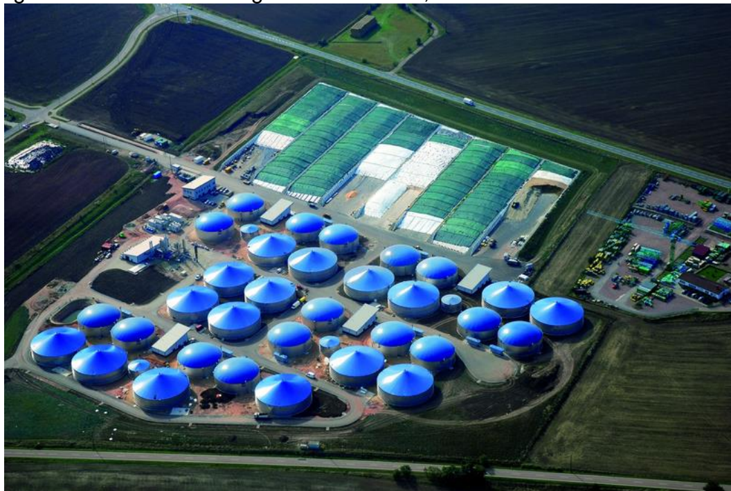
Figura 6 - Refinaria de biogás na Alemanha, no estado de Saxônia-Anhalt
