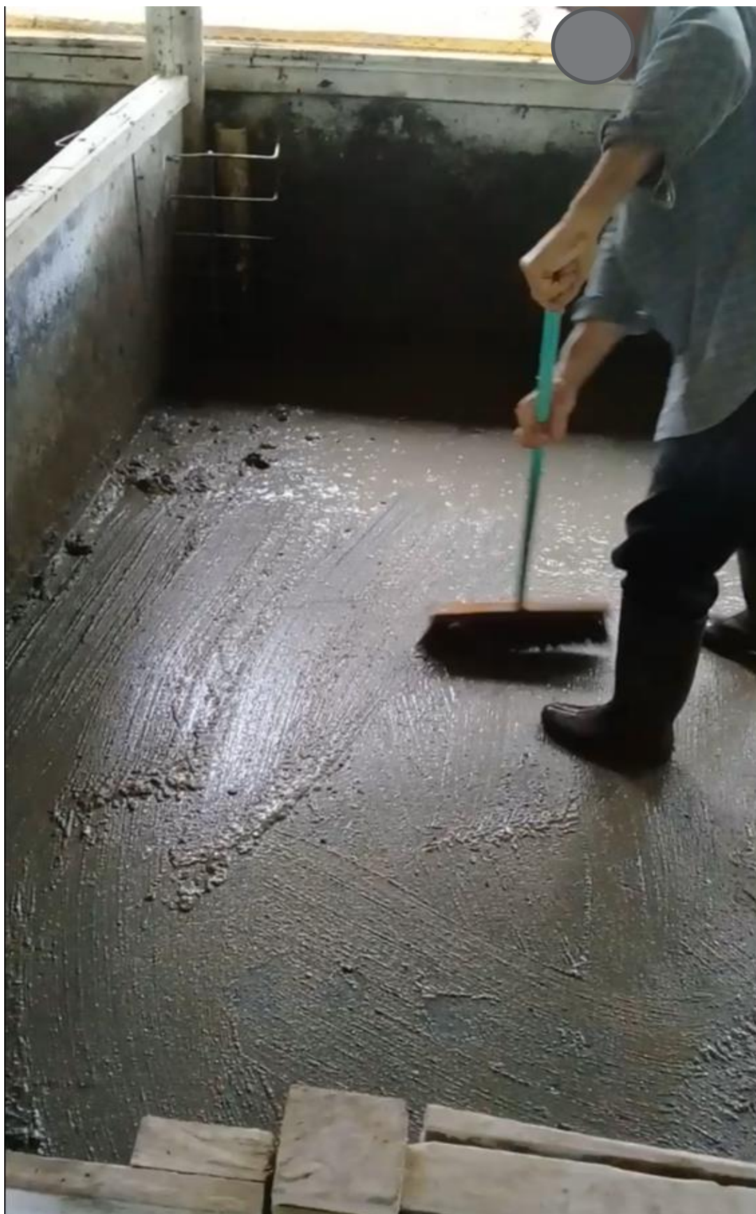
Figura 30 - Baia após limpeza manual
