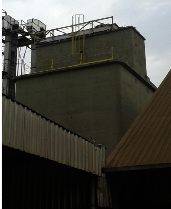
Figura 5: Regulador de umidade
