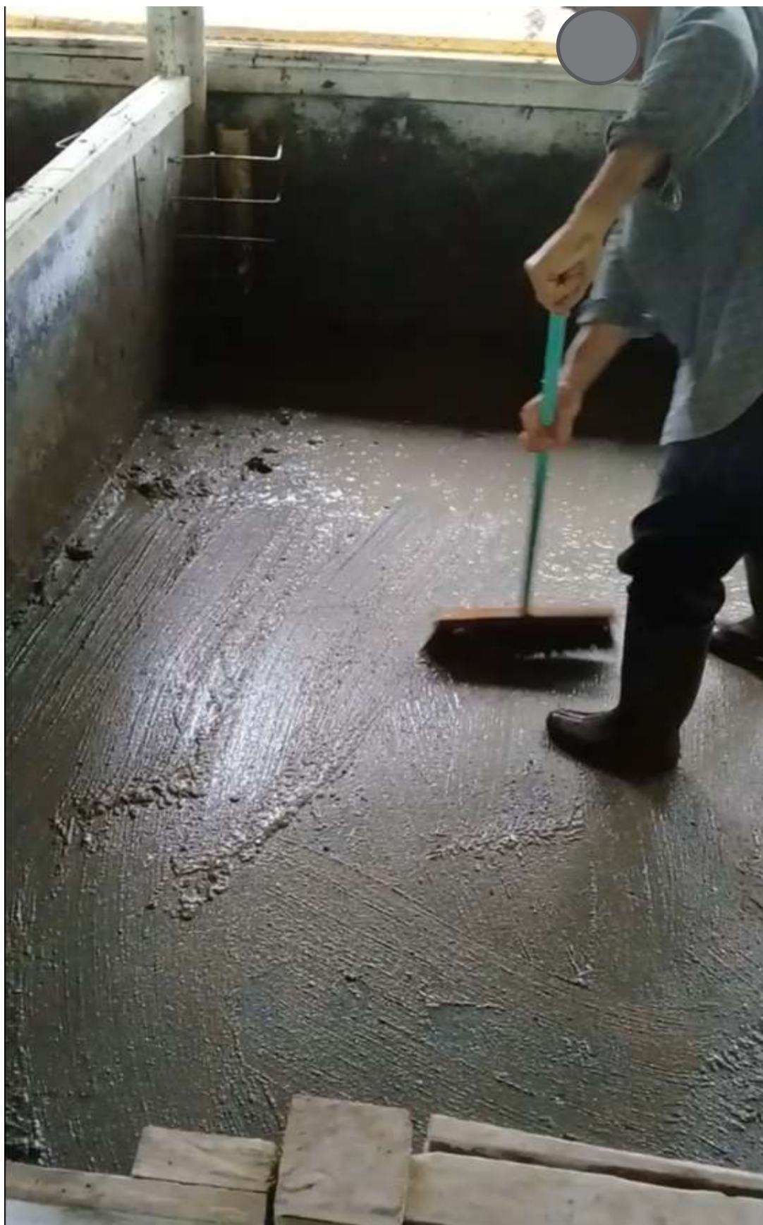
Figura 30 - Baia após limpeza manual
