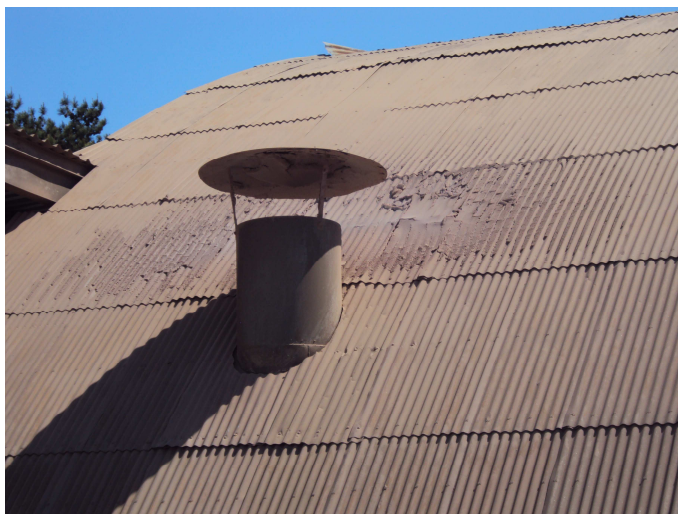
Figura 10: Telhado da empresa na área de pintura
