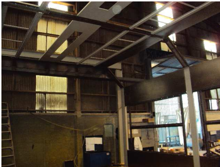
Figura 23: Montagem da cabine pintura.
