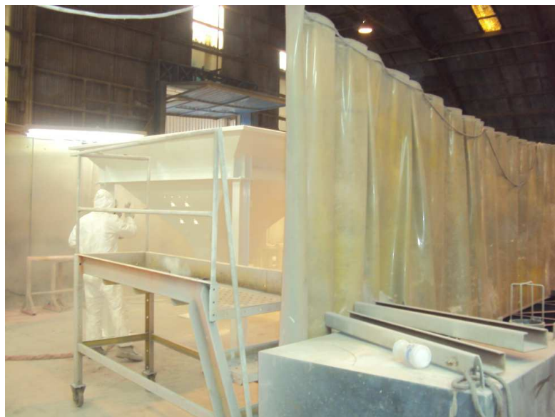
Figura 7: Cabine de pintura
