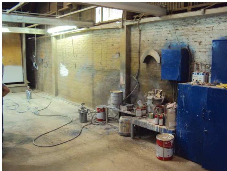
Figura 8: Cabine de pintura
