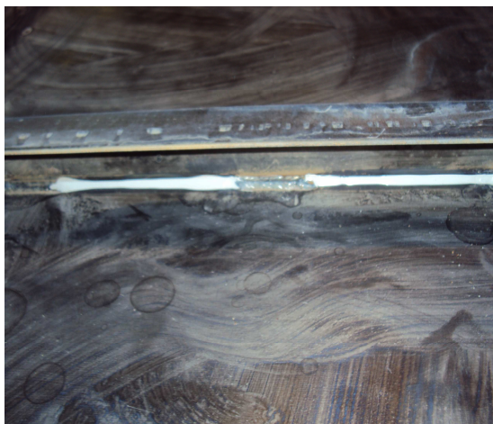
Figura 18: Aplicação de adesivo selante
