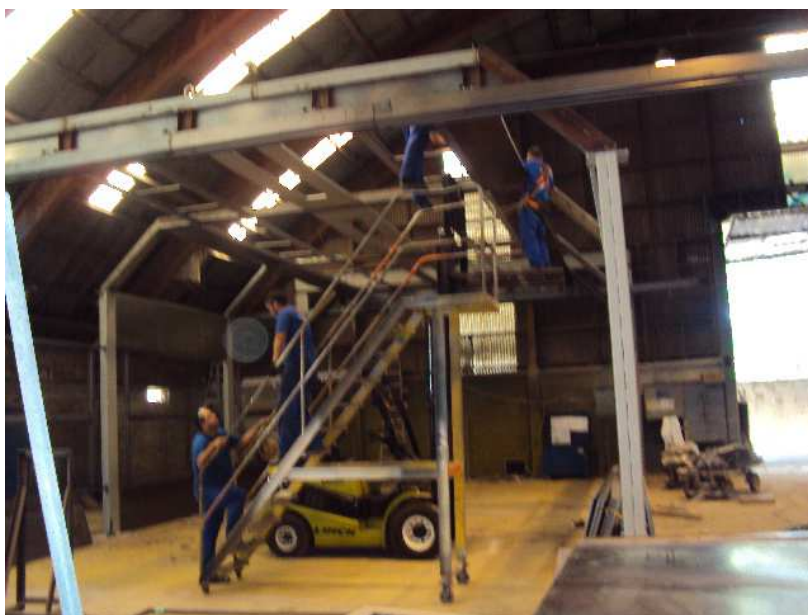
Figura 22: Início da montagem.
