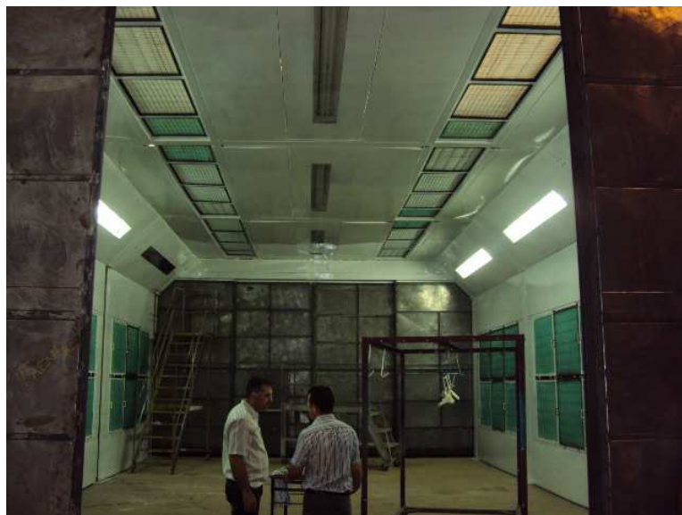
Figura 24: Finalização da montagem.
