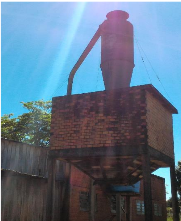
Figura 16 – Canalização do exaustor, passando pelo ciclone que despeja no depósito de estocagem.
