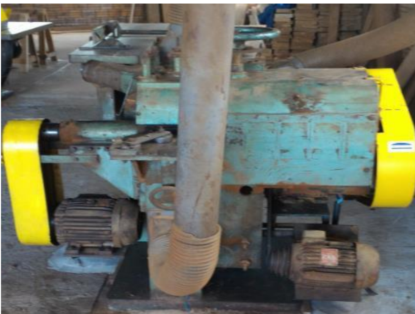
Figura 10 - Proteção nas partes móveis de metal da plaina moldureira.
