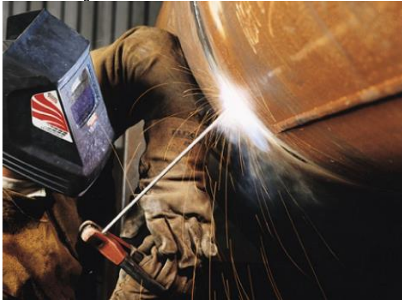
Figura 22 – Processo de soldagem
