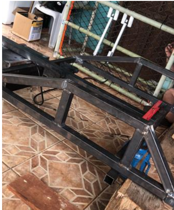
Figura 36 – Soldagem reforços chassis
