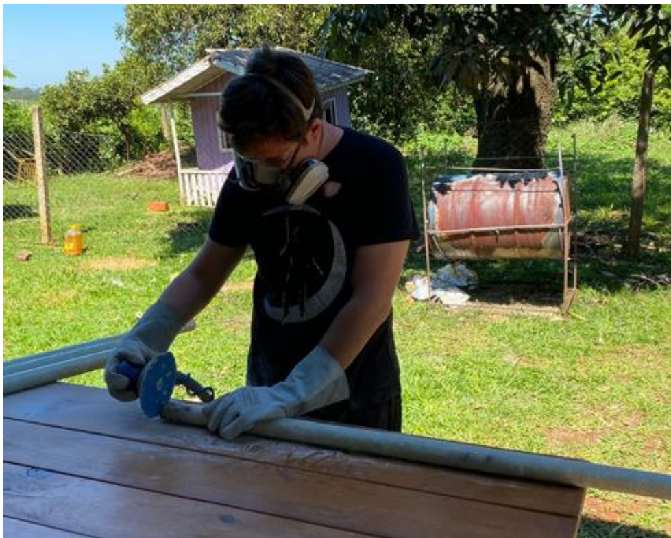
Figura 27 – Processo de lixamento dos tubos de PVC laminados com fibra de vidro
